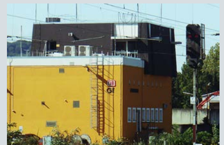
Das Stellwerk Gelnhausen heute.
