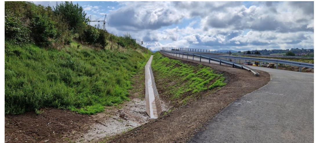
Entwässerung der Autobahn über eine versiegelte Mulde zwischen WW und A66
