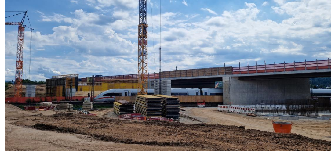
Blick aus Richtung Nordost auf das Baufeld für das zweite Teilbauwerk
