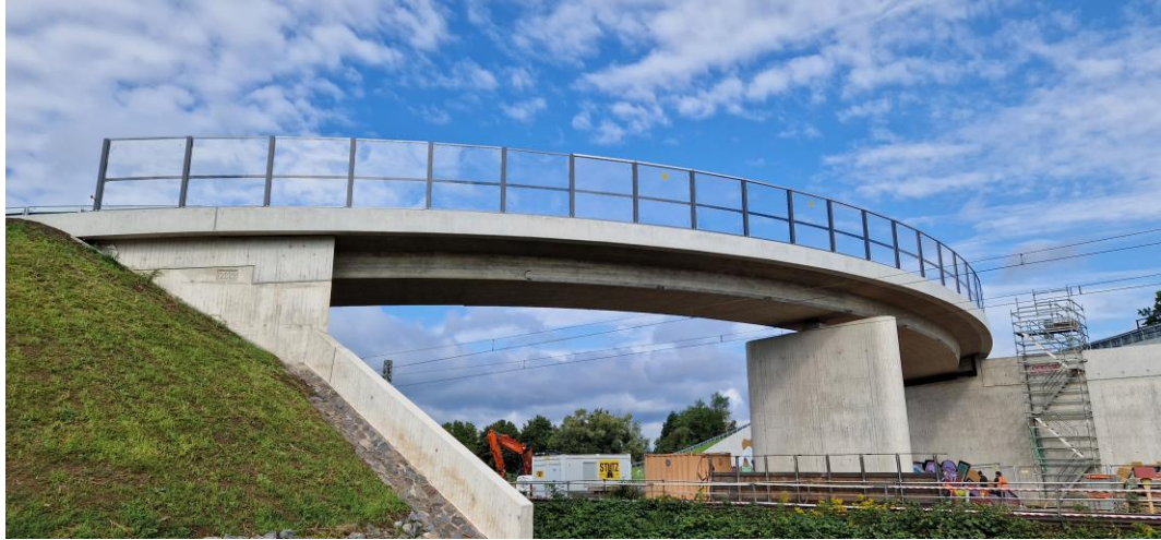
Wirtschaftswegebrücke als Ersatz für den Bahnübergang Bleichstraße
