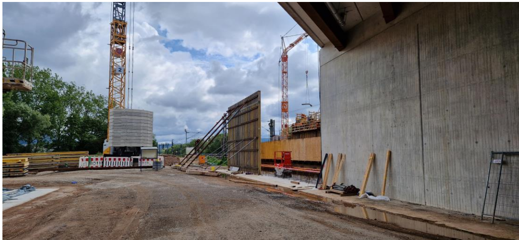
Beginn Schalungsarbeiten Mittelstütze des zweiten Teilbauwerks
