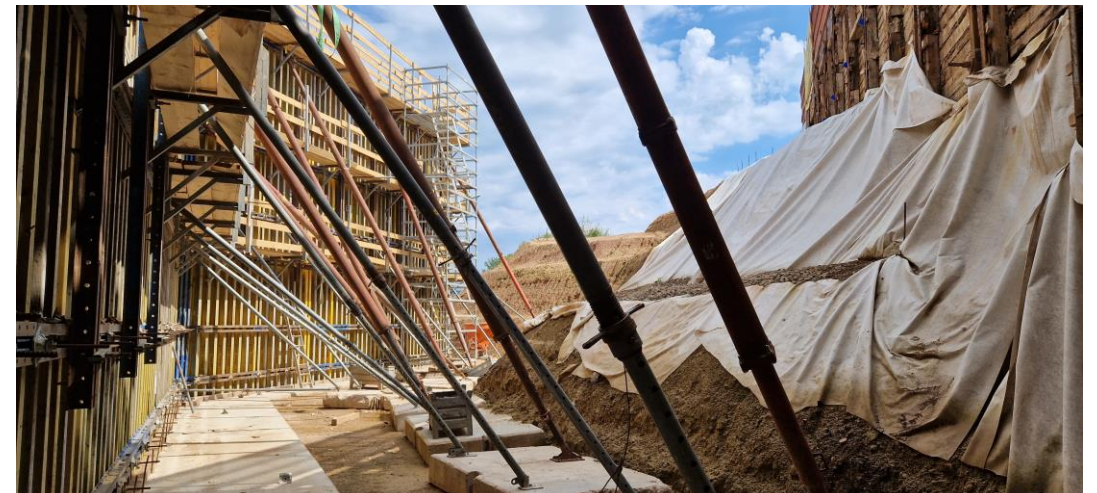
Schalungsarbeiten Mittelstütze des südlichen Widerlagers des 2. Teilbauwerk
