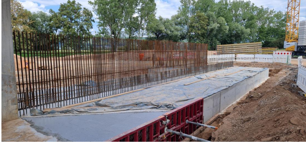
Gründung des nördlichen Widerlagers des zweiten Teilbauwerks (Pfahlkopfplatte)
