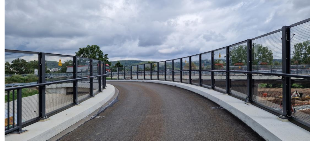
Sicht auf dem Bauwerk mit Schrammbord, Berührschutz und Geländer
