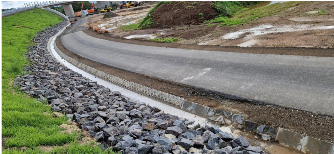
Fortlaufend Straßenbauarbeiten für die Wirtschaftswege am Damfuß
