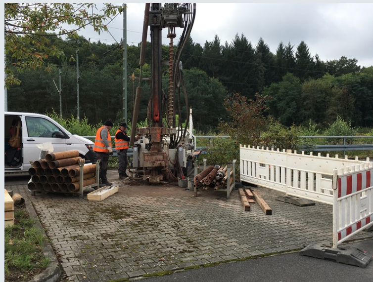
Kleinrammbohrung in Langenselbold (Bahnhof) am 19. September 2017
