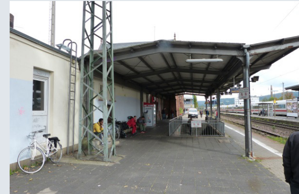
Aktuelle Bahnsteigüberdachung Gelnhausen
